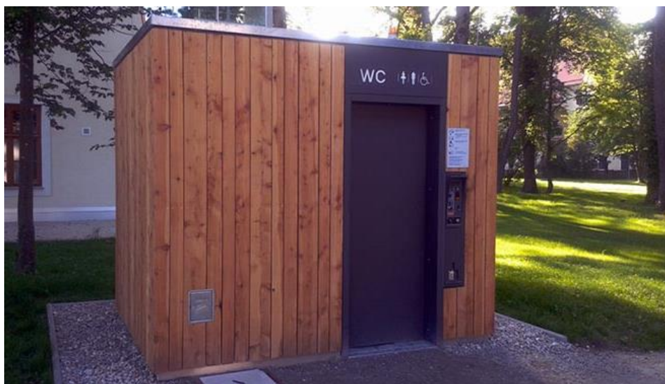
Beispiel einer öffentlich zugänglichen WC-Anlage
