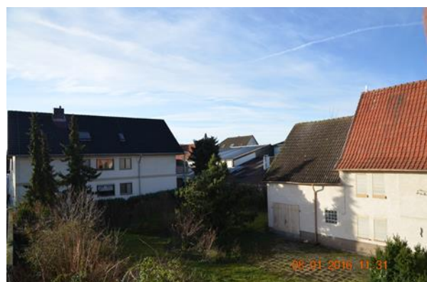
Hof mit Nebengebäude
